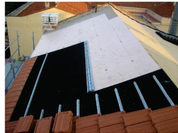
94. Construcción de cubierta inclinada con aislamiento en forjado inclinado. Fuente: ursa.es
