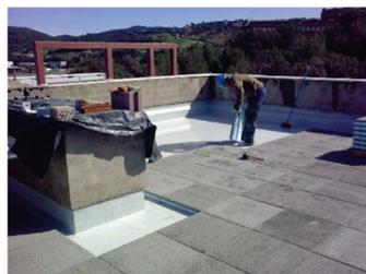
85. Aislamiento de baldosas de XPS en cubierta plana invertida. Fuente: danosa.es
