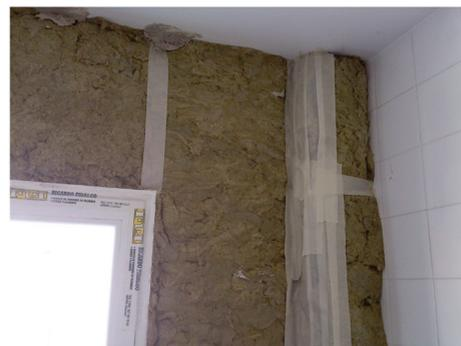
76. Instalación de trasdosado de aislamiento térmico en cuarto húmedo
