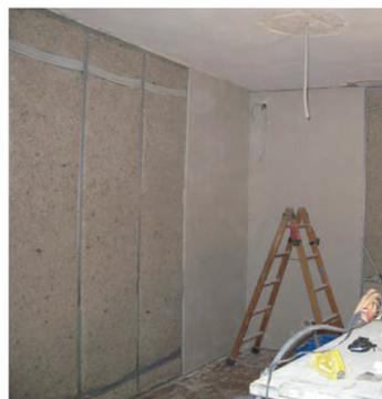
69. Colocación de aislamiento térmico al interior con panel de cartón yeso con barrera de vapor.
