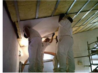
86. Aislamiento térmico por el interior en cubierta.
