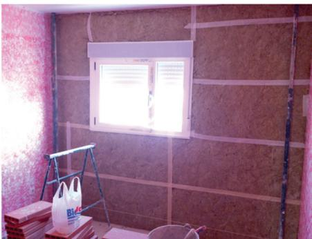
75. Instalación de trasdosado de aislamiento térmico
