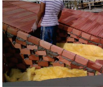
91. Construcción de cubierta inclinada con aislamiento en paño horizontal. Fuente: ursa.es
