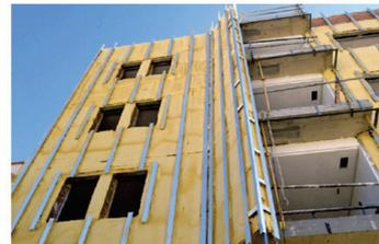
78. Aislamiento térmico proyectado y subestructura de fachada ventilada. Fuente: arquys.com
