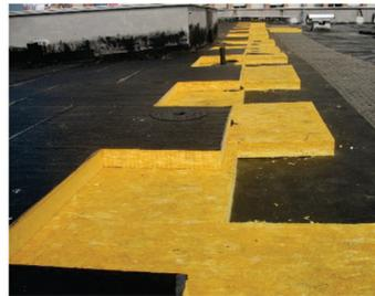
83. Cubierta plana tradicional con aislamiento bajo la formación de pendiente. Fuente: bituver.it
