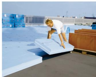
84. Aislamiento de paneles de XPS en cubierta plana invertida. Fuente: danosa.es
