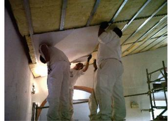
93. Aislamiento térmico por el interior en cubierta.
