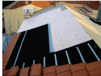
92. Construcción de cubierta inclinada con aislamiento en paño inclinado. Fuente: ursa.es
