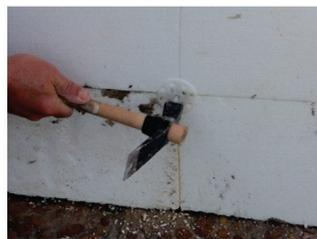
73. Fijación de paneles con espigas
