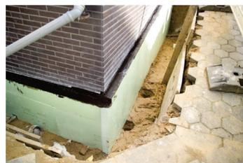
67. Aislamiento térmico por el exterior en muro de sótano.
