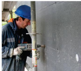
68. Colocación de anclajes mecánicos en aislamiento térmico exterior.
