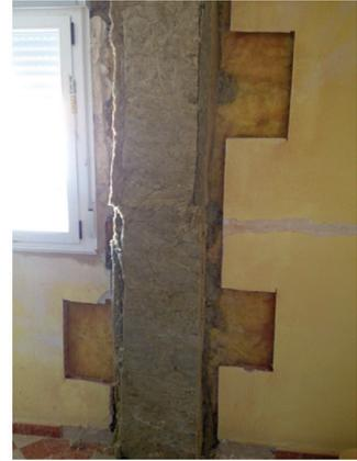
74. Instalación de trasdosado de aislamiento térmico en pilares
