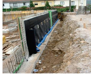
64. Colocación de lámina impermeabilizante al exterior de muro de sótano.
