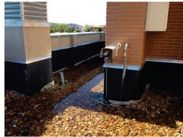
88. Cubierta aljibe con equipo de llenado automático y nivel de agua.
