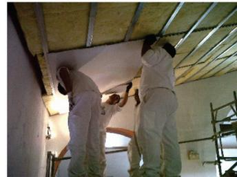
95. Aislamiento térmico por el interior en cubierta. Fuente: ursa.es
