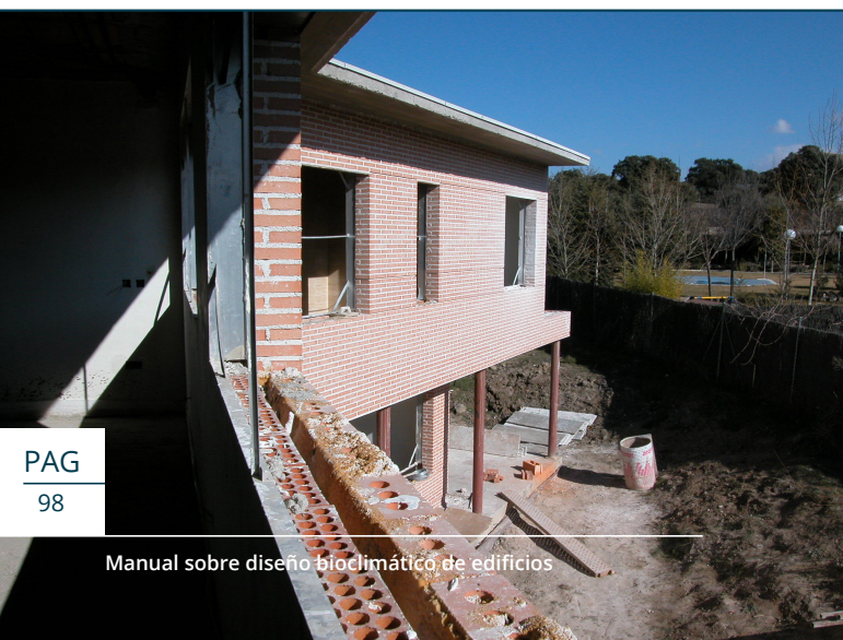
Cerramiento con el muro acumulador situado hacia el interior del local
