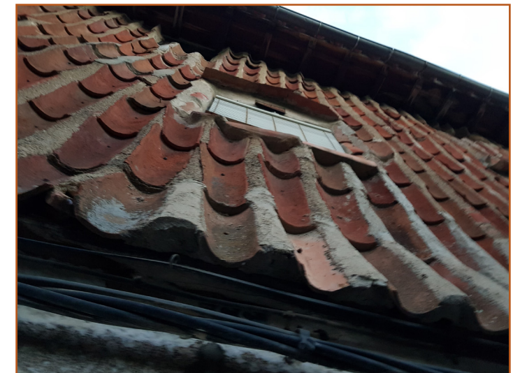
Fachada recubierta con teja cerámica en posición vertical, casi siempre la canal
