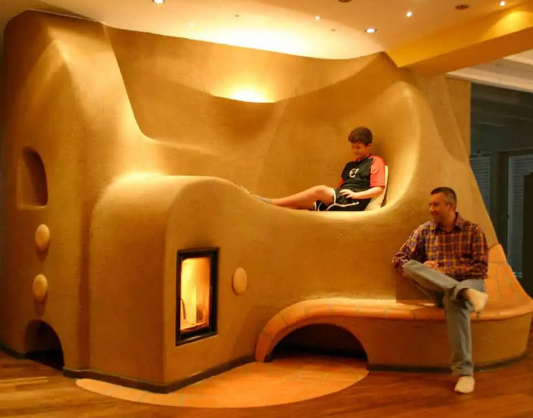
Estufa de inercia térmica rocket, https://teoriadeconstruccion.net
