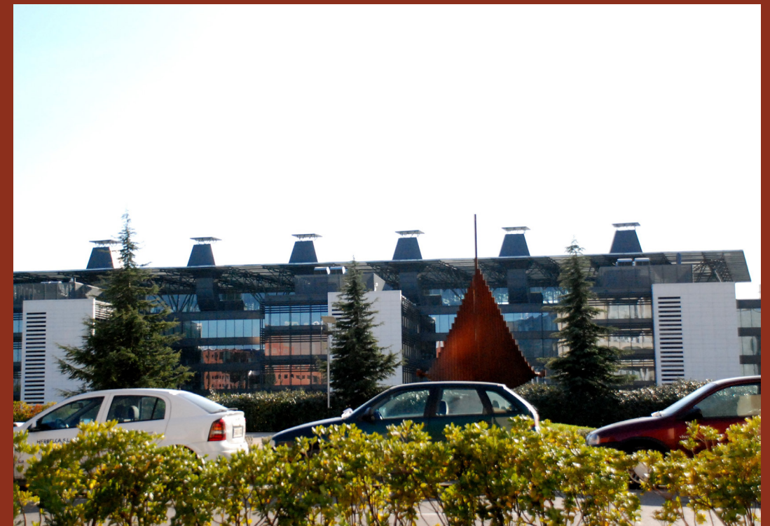
Edificio de Endesa, con dispositivos de ventilación natural mediante chimeneas térmicas
