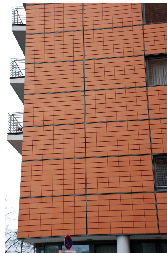
Fachada ventilada cerámica en un edificio en Berlín
