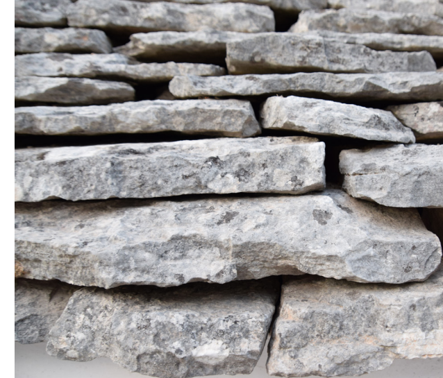
Imagen de las lajas de chiancarelle de una cubierta
