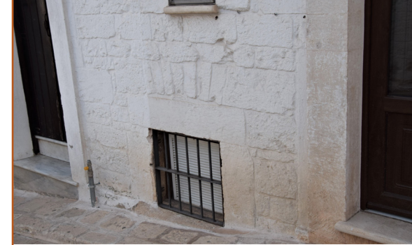
Rejilla de ventilación del aljibe situada en el muro exterior
