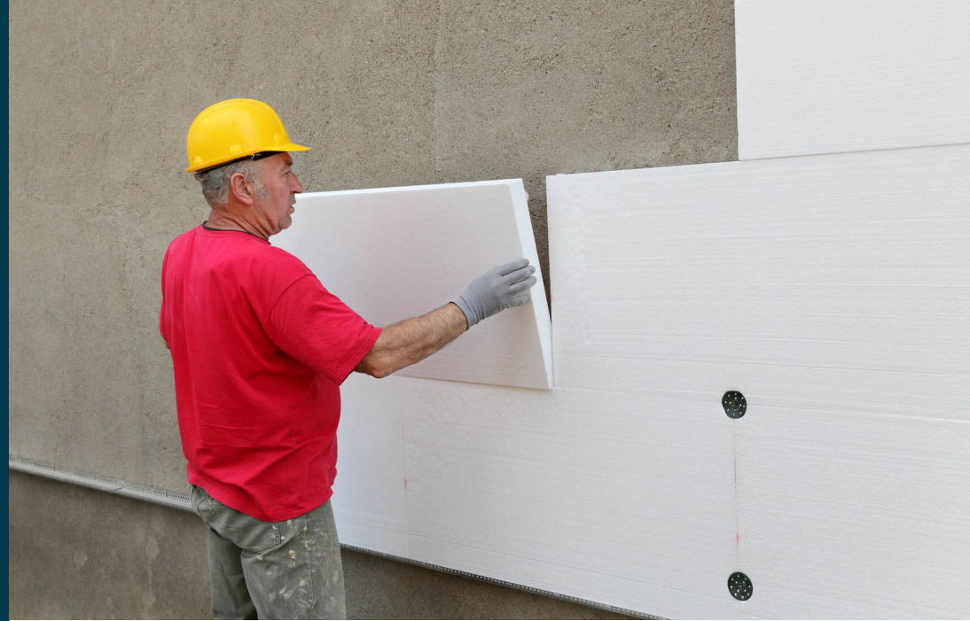
Instalación de sistema SATE en fachadas, https://jgyparquitectos.com
