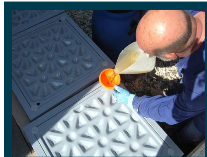
Sistemas de almacenamiento de energía en parafina: A granel, relleno la base de baldosas cerámicas
