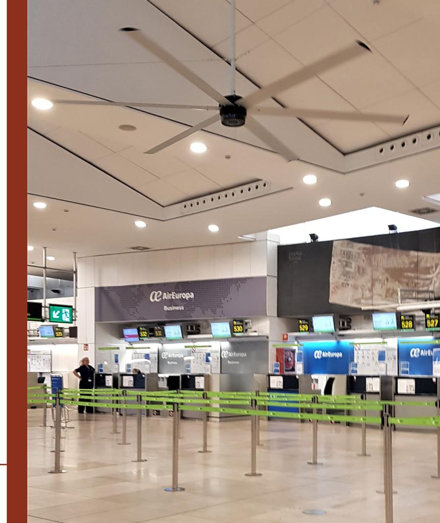
Grandes ventiladores de techo en la T2 del aeropuerto de Barajas en Madrid. Estos sistemas permiten ahorrar mucha energía de refrigeración al reducir directamente la sensación de calor
