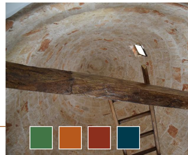
Foto de un cono por el interior donde se ve la transición entre el cuadrado y el círculo
