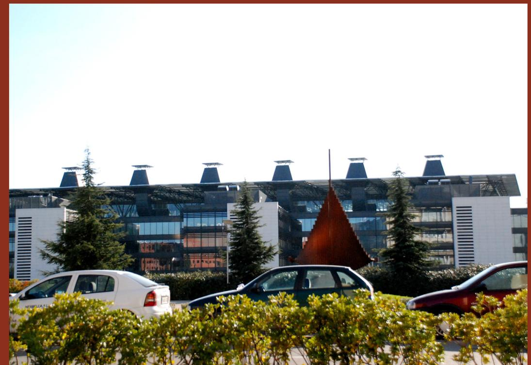
Edificio de Endesa, con dispositivos de ventilación natural mediante chimeneas térmicas
