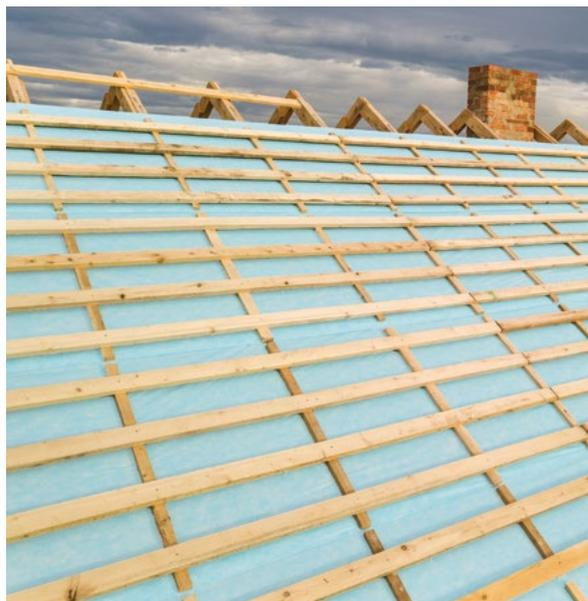
Figura 37 - Aislamiento de cubiertas inclinadas con XPS.
