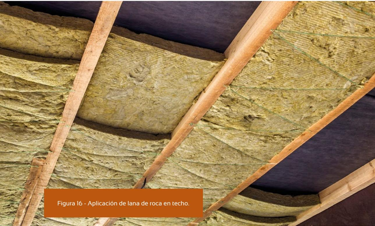
Figura 16 - Aplicación de lana de roca en techo.
