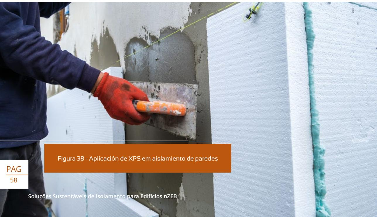
Figura 38 - Aplicación de XPS em aislamiento de paredes
