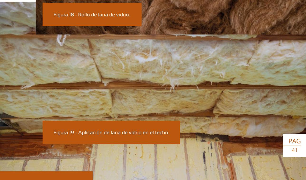
Figura 19 - Aplicación de lana de vidrio en el techo.
