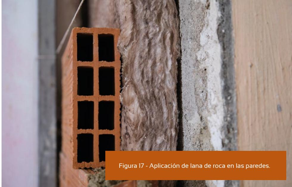
Figura 17 - Aplicación de lana de roca en las paredes.
