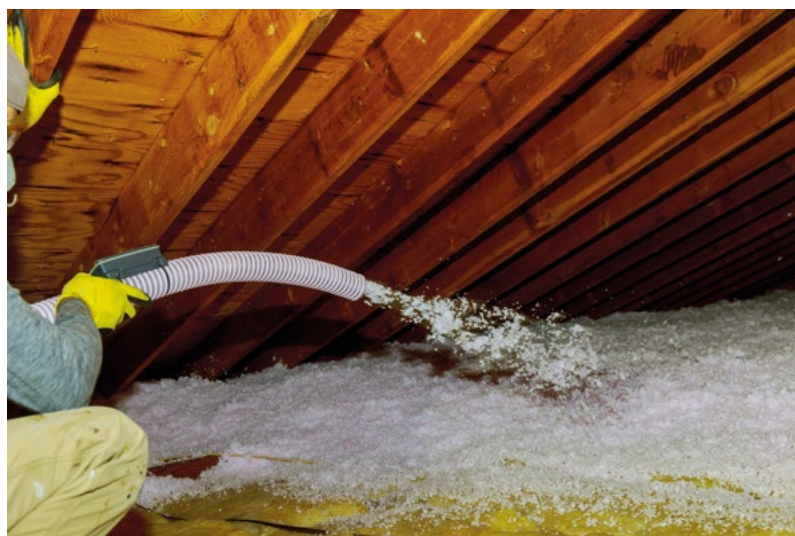
Figura 27 - Isolamento de sótão com celulose
