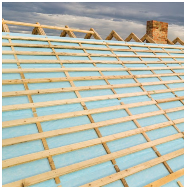
Figura 37 - Isolamento de coberturas inclinadas com XPS
