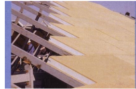
Bases de cubierta
