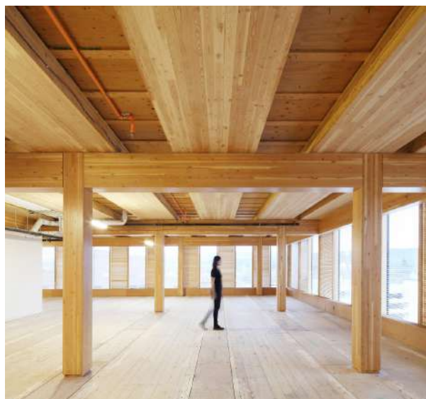
Estructura de tableros contralaminados , https://www.archdaily.com
