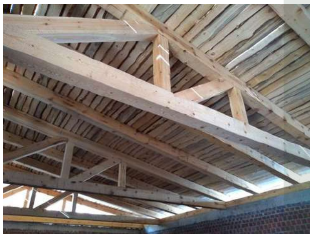
Escuadrías de madera aserrada estructural de pino laricio, https://www.maderascuenca.com/
