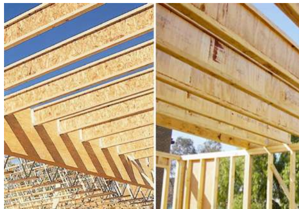
Estructuras mixtas: (izq) viguetas de pino + alma de OSB; (der) viguetas de pino + alma de contrachapado, https://ecohabitar.org
