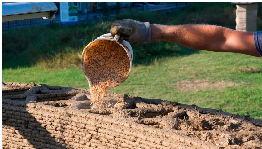
Relleno de pared con cáscara de arroz, Ricehouse, 2021
