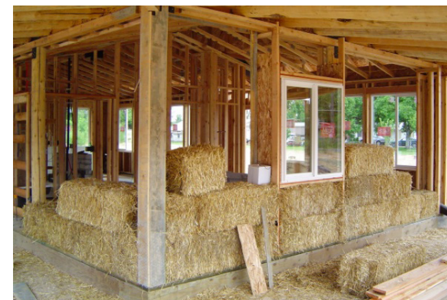
Estructura de postes y vigas, https://www.sacyr.com/
