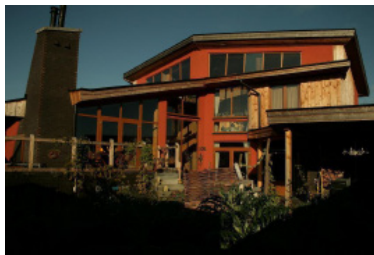
Vivienda unifamiliar realizada con sistema CUT (2009-2011) en Veghel, Países Bajos, Romans Torres, 2014
