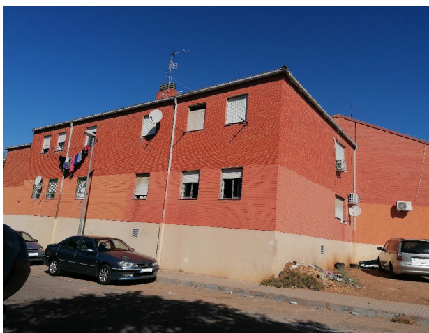
Estado inicial de las viviendas. Fachada 2
