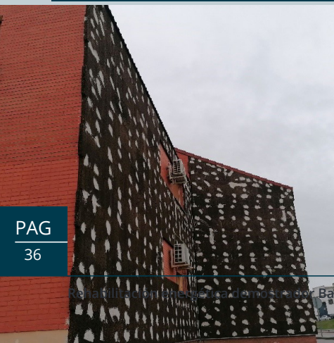
Colocación de SATE con aislamiento de corcho natural
