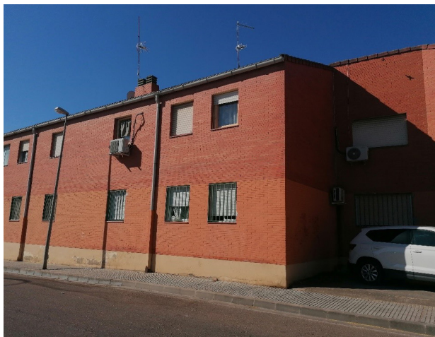
Estado inicial de las viviendas. Fachada 1
