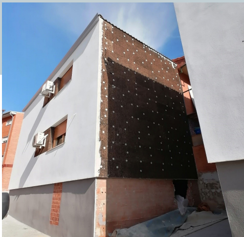
Detalle colocación SATE y acabado
