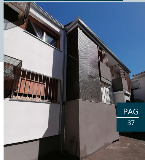
Detalle patios interiores cerrados con chapa deployé
