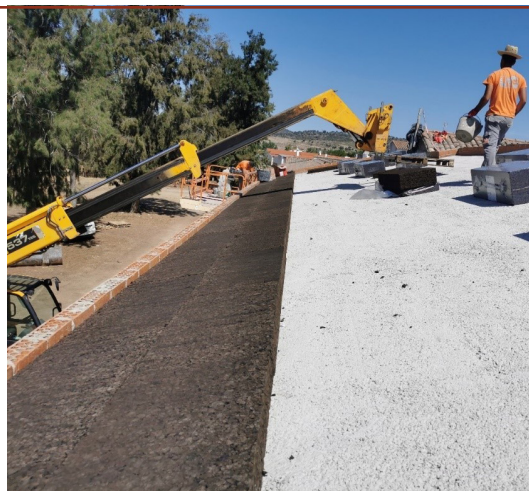
Trabajos en cubierta
