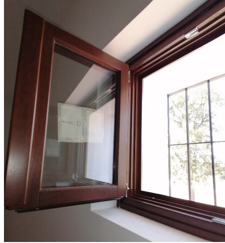
Detalle carpintería colocada
