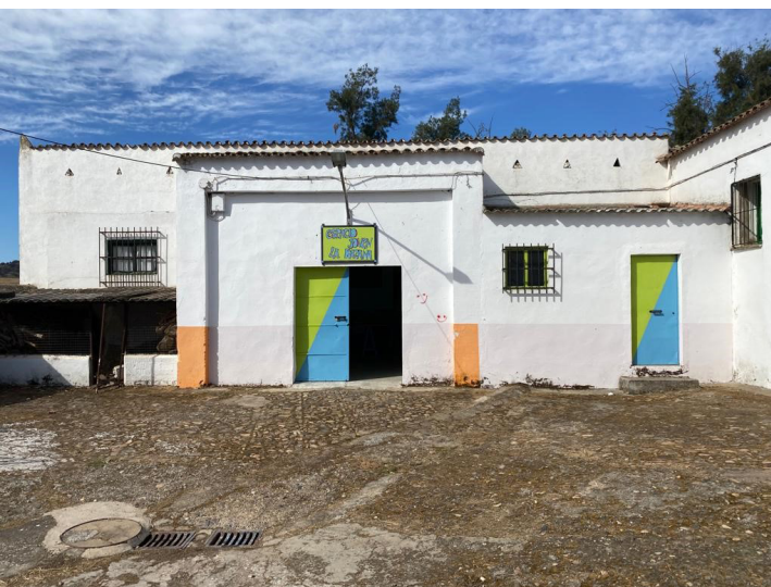
Fachada del edificio A de la Hermandad Sindical de La Bazana antes de la rehabilitación
