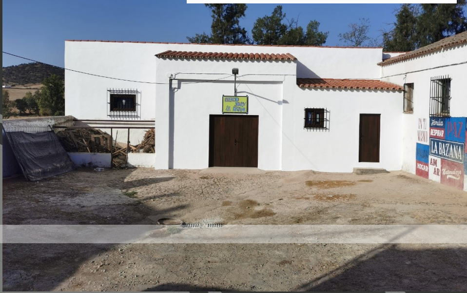
Fachada del edificio La Hermandad Sindical, edificio A, tras la rehabilitación
