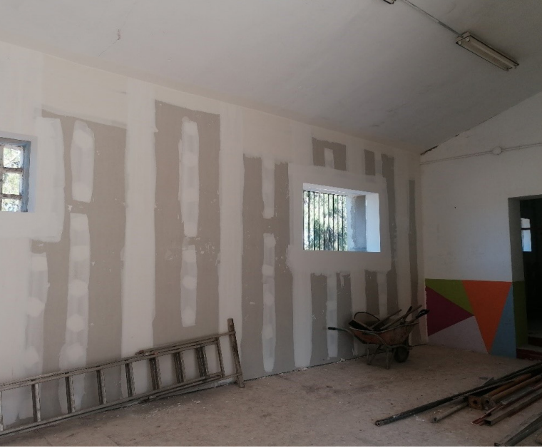
Detalle ejecución trasdosado interior
