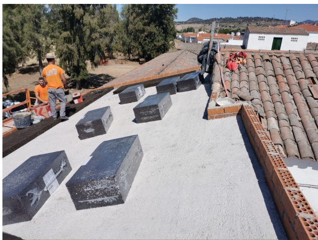
Colocación del aislamiento térmico en cubierta inclinada
