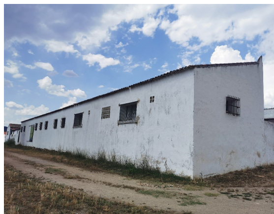
Fachada trasera y lateral antes de la rehabilitación
