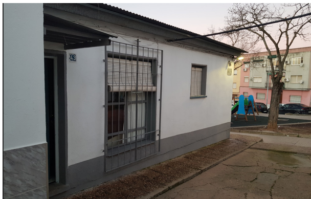
Estado actual Vivienda 3. Calle Halcón 43
