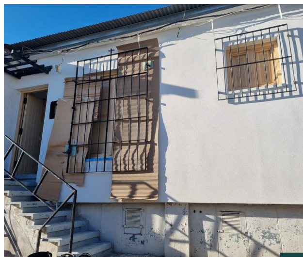
Colocación defensas en ventanas exteriores
