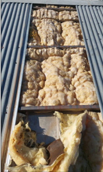
Levantado de elemento cubierta
