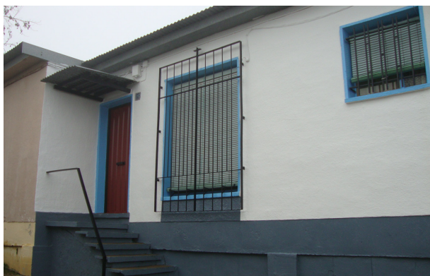
Estado actual Vivienda 4. Calle Ebro 41
