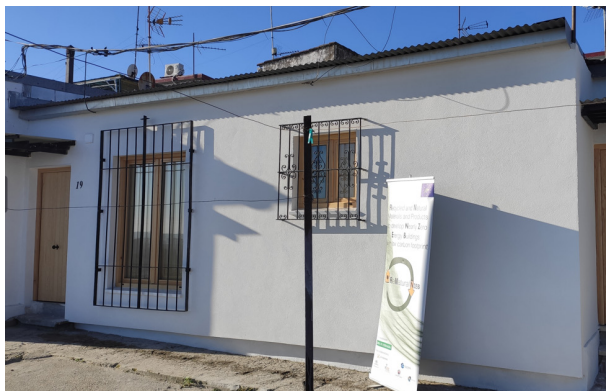
Estado final Vivienda 1. Calle Duero 19
