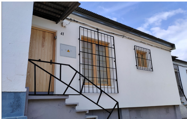
Estado final Vivienda 4. Calle Ebro 41
