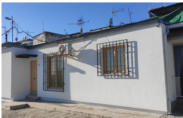
Estado final Vivienda 2. Calle Duero 21
